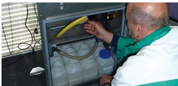
Abb. 1: Installation des automatischen Probennehmers – das Abwasser kann vom Kanal zu diesem hinaufgepumpt werden
